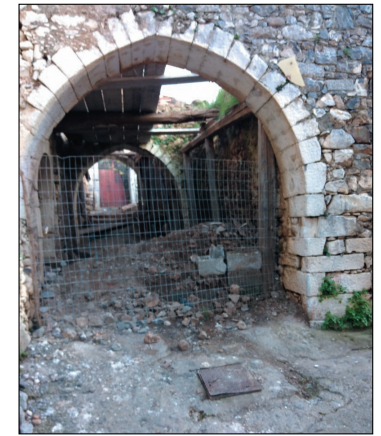
Οι καμάρες υποστύλωνται
